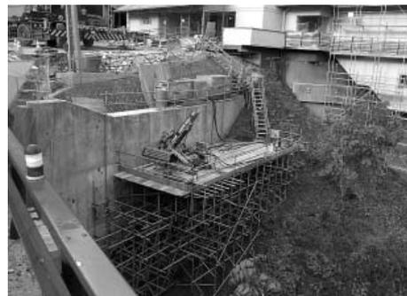
擁壁部アンカー施工状況
