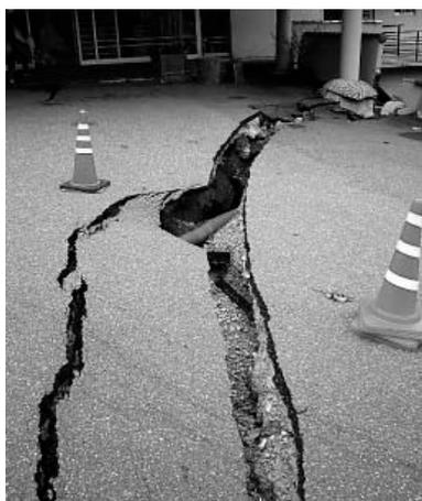
擁壁上部地盤の沈下
